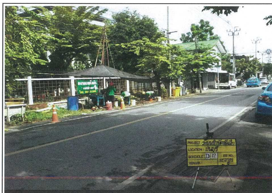
ภาพถ่ายแสดงตำแหน่งหลุมเจาะ D-12
