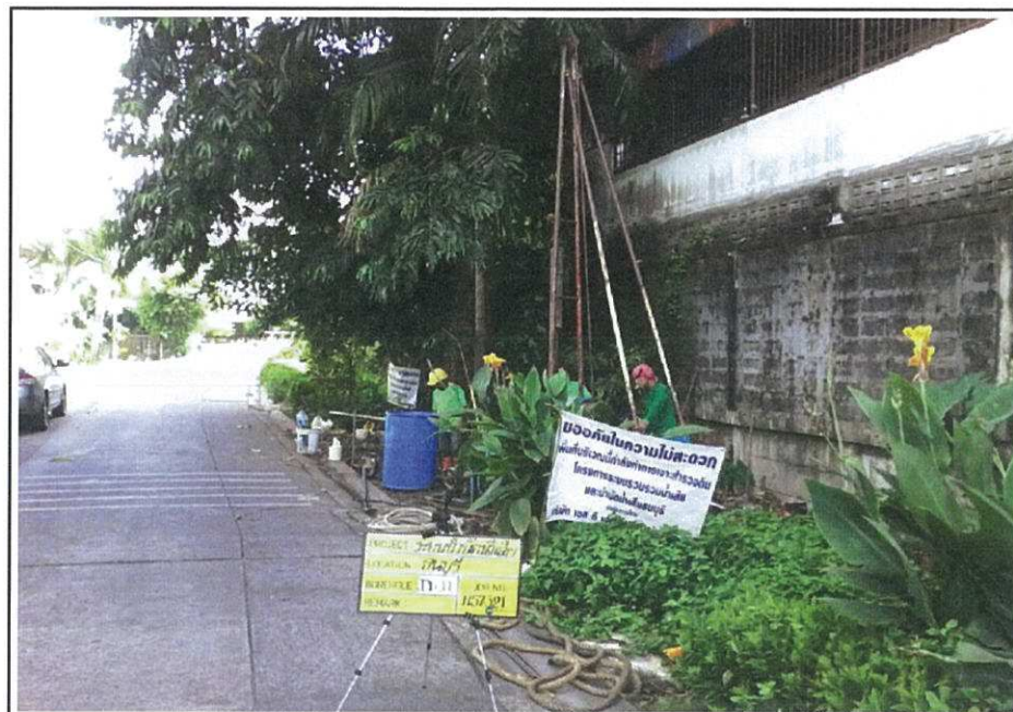
ภาพถ่ายแสดงตำแหน่งหลุมเจาะ D-11
