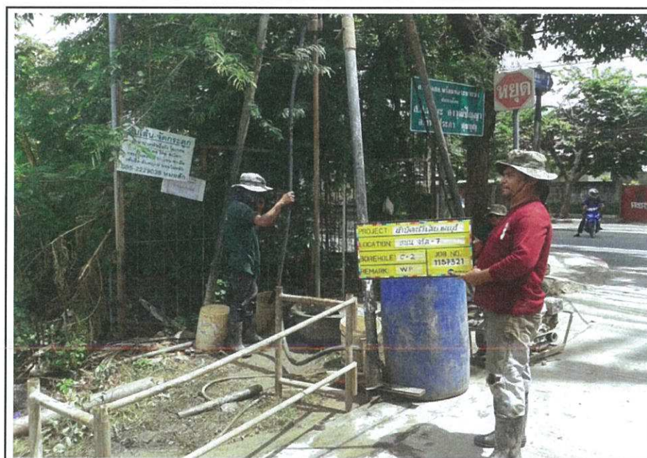
ภาพถ่ายแสดงตำแหน่งหลุมเจาะ C-2
